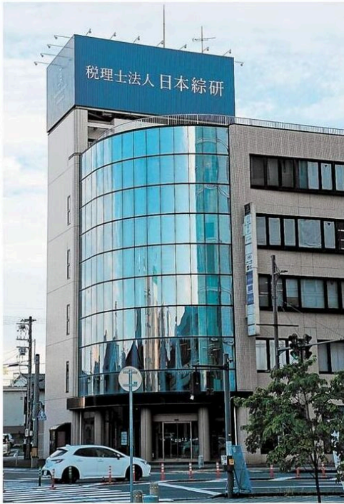
日本綜研の本部が入居するビル＝福井市手寄1丁目
